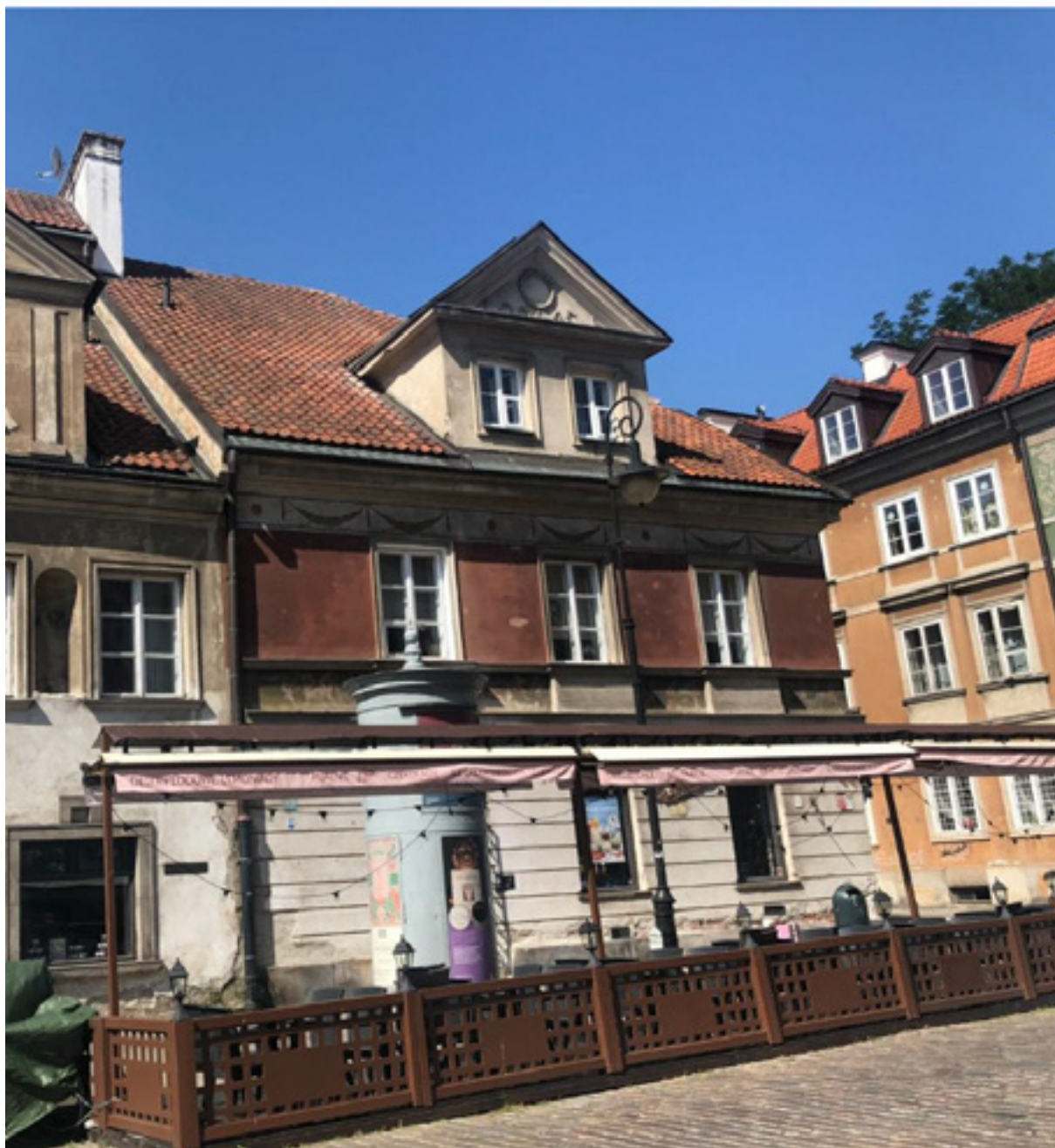
Il. 70. Widok od strony ulicy Freta dekoracji fasady narożnego domu przy ul. Freta 13/15, fot. Aleksandra Juszczyk
