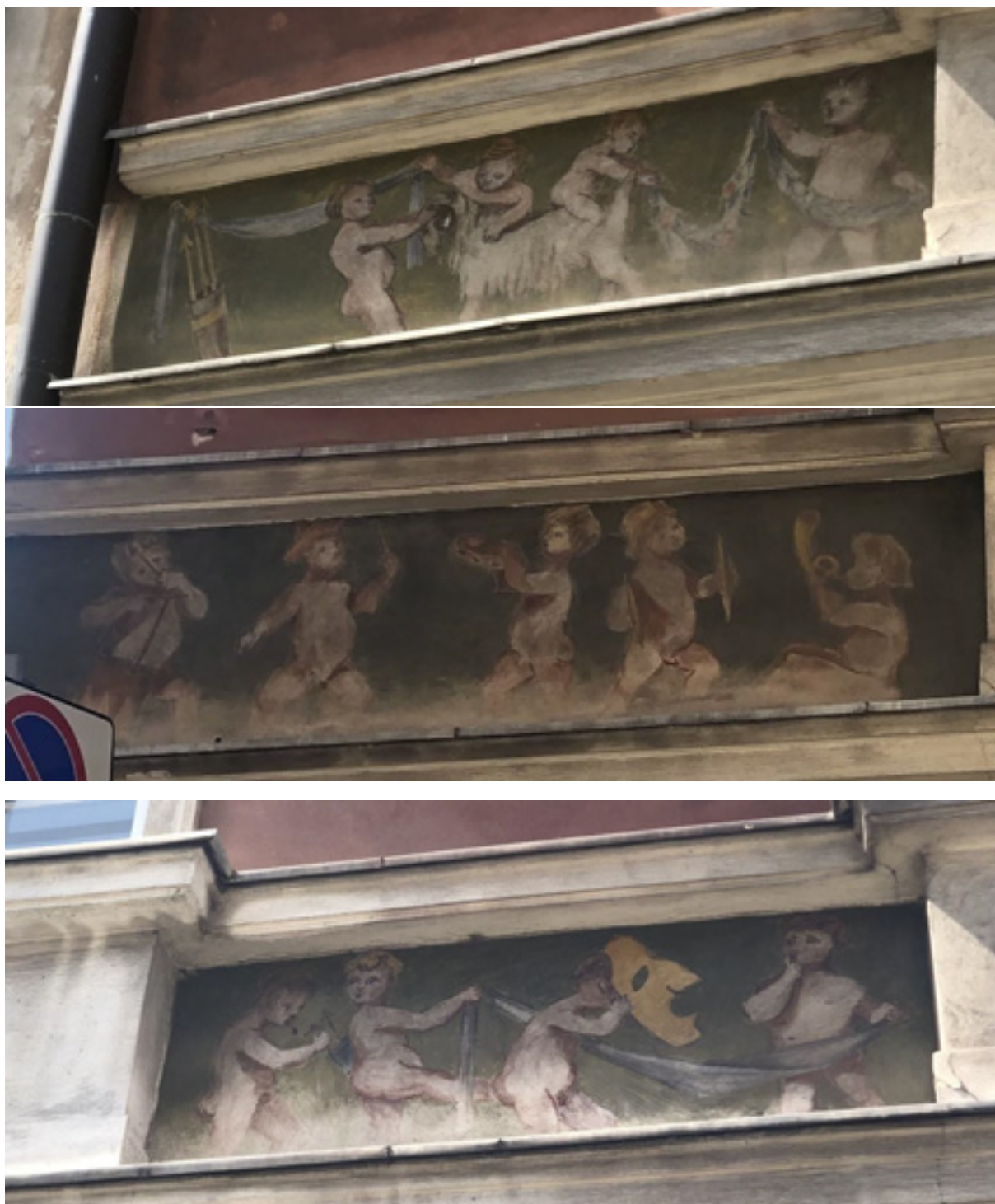
Il. 69. Detale dekoracji fasady narożnego domu przy ul. Freta 13/15, fot. Aleksandra Juszczuk
